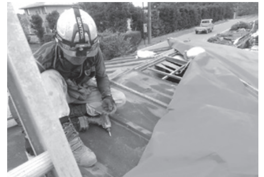
【屋根の補修・ブルーシート養生】
