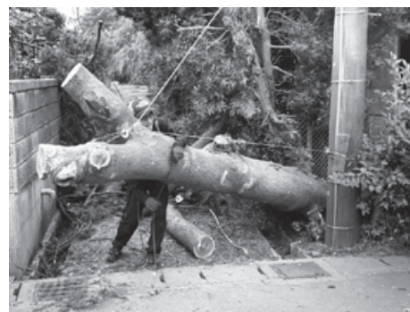
【敷地の倒木撤去作業】
